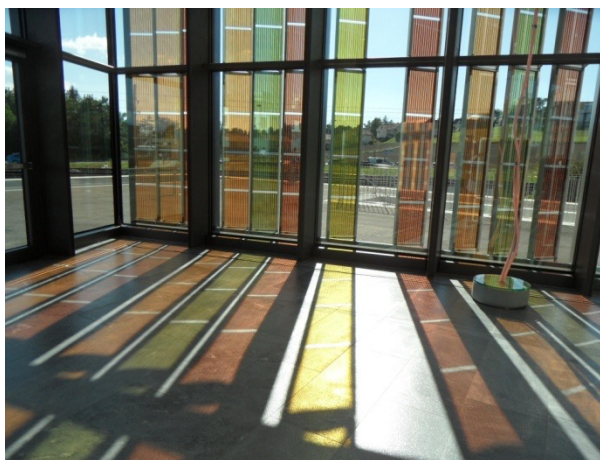
Figura 1. Paneles DSSC en los ventanales del Centro Suizo de Convenciones, situado en la ciudad de Lausana.
